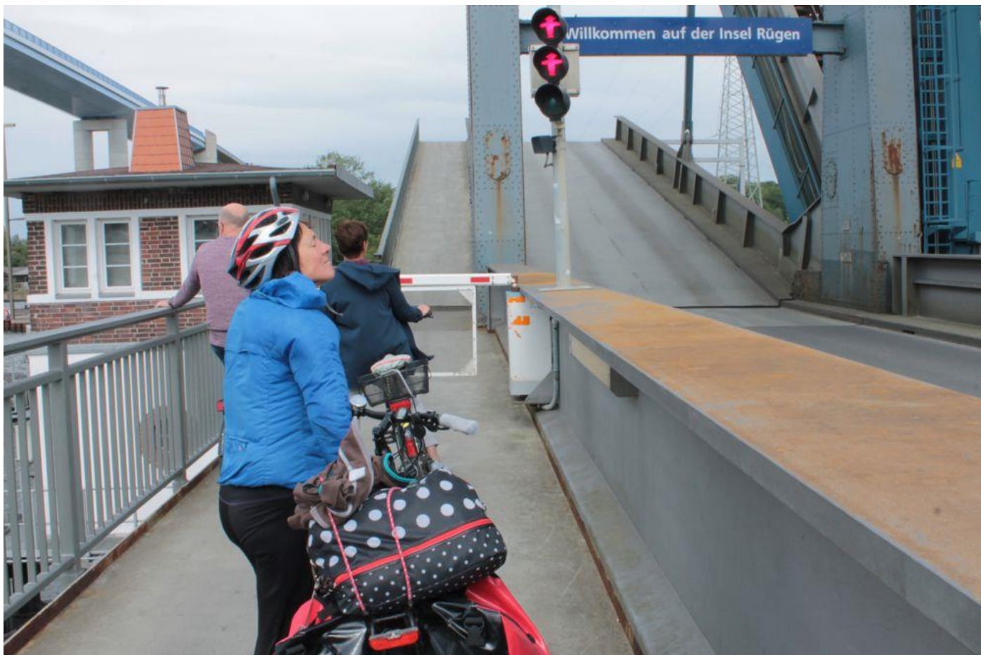
Auf der Zug-, Fußgänger-, Radfahrer- und Autobrücke von Stralsund auf die Insel Rügen ↑
